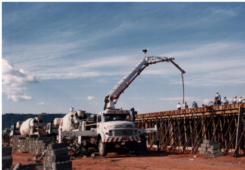
FIGURA 13 – Autobomba dotada de lança de distribuição para lançamento do concreto em grandes quantidades e a grandes distâncias.
