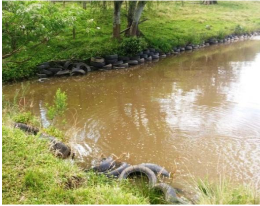
Figura 5 - Taipa protegida com pneus
