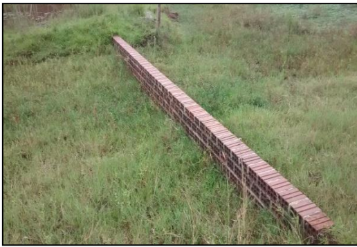
Figura 7 - Taipa de tijolos
