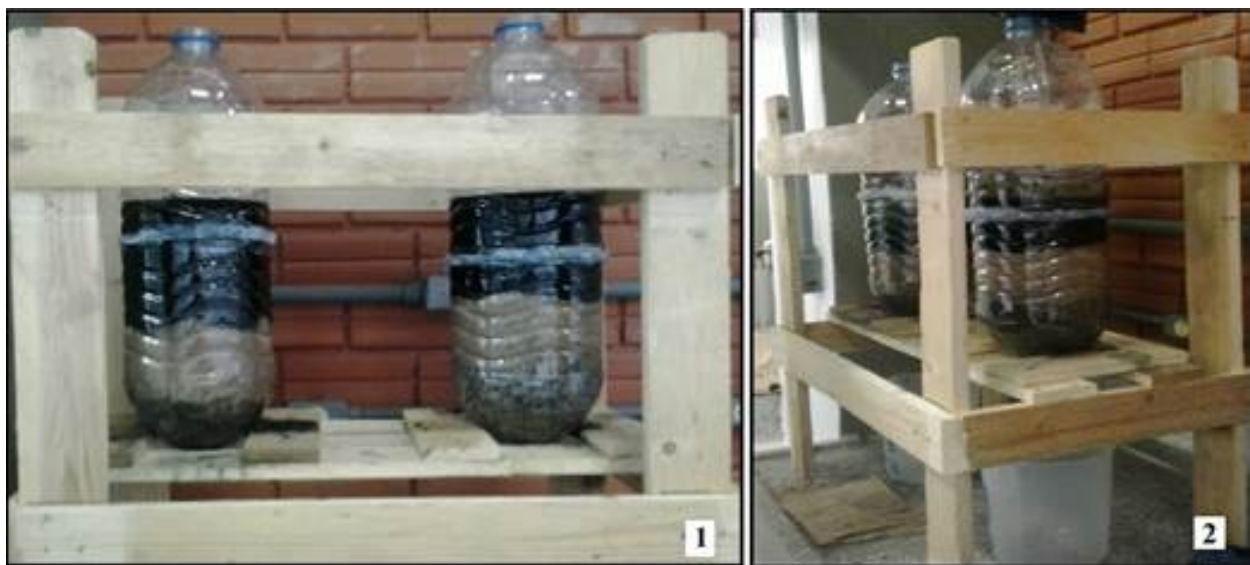
Figura 19 - Estrutura dos filtros: 1 - filtros durante a montagem e 2 - filtros durante a lavagem. Filtro 1 à direita na figura e Filtro 2 à esquerda na figura.
