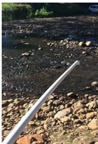
Figura 20 - Ponto de lançamento de efluente doméstico no Arroio Hermes.
